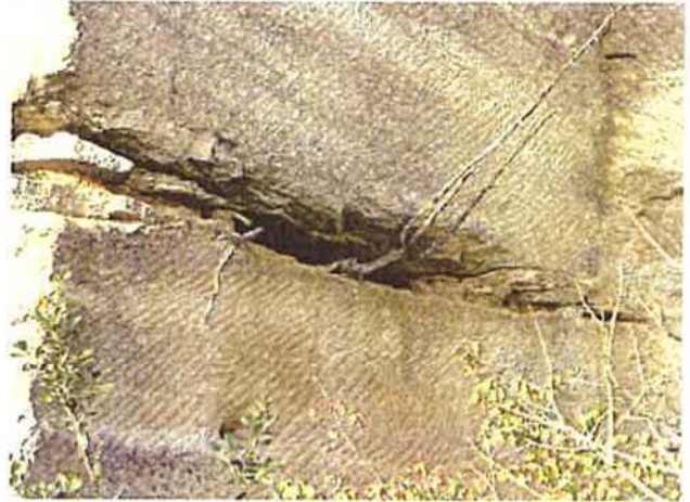
Fissure horizontale ouverte – carrière de Bonillet
