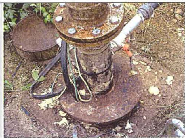
Vue de la tête du forage
